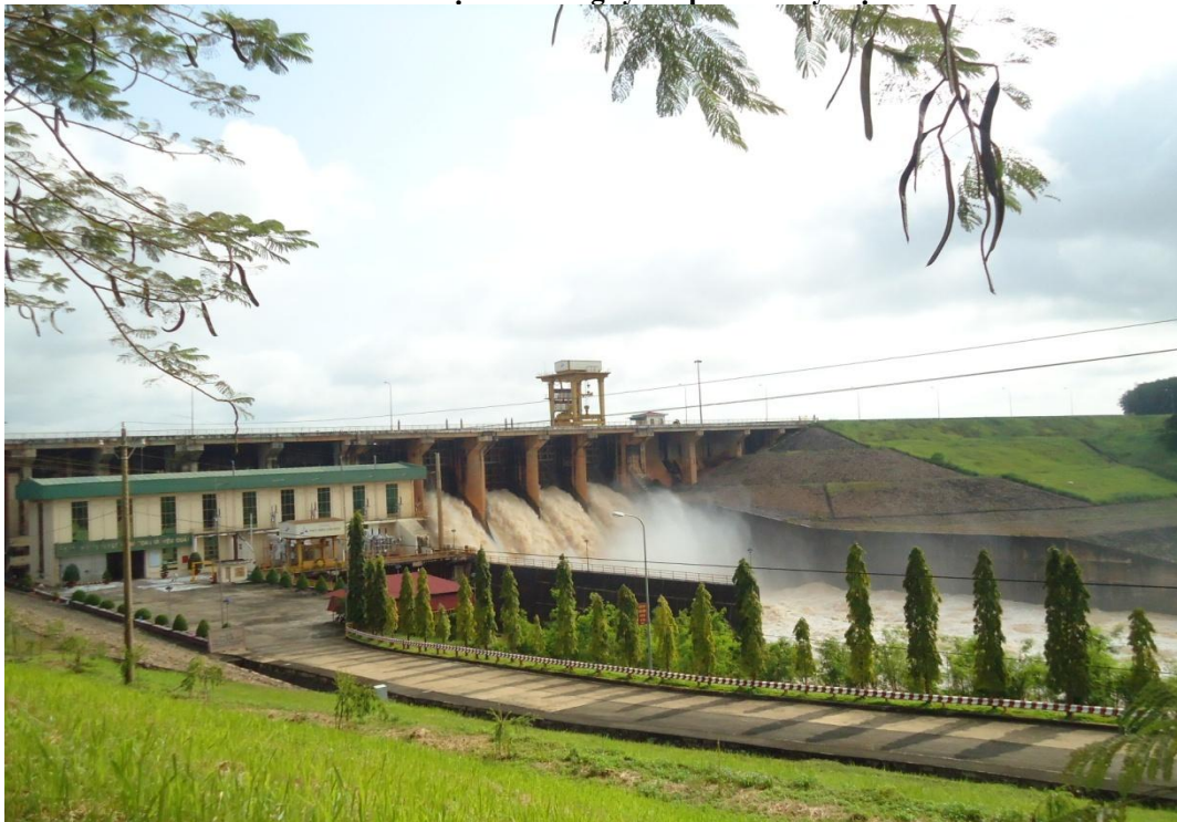
Hình ảnh Nhà máy thủy điện Cần Đơn đang xả tràn
