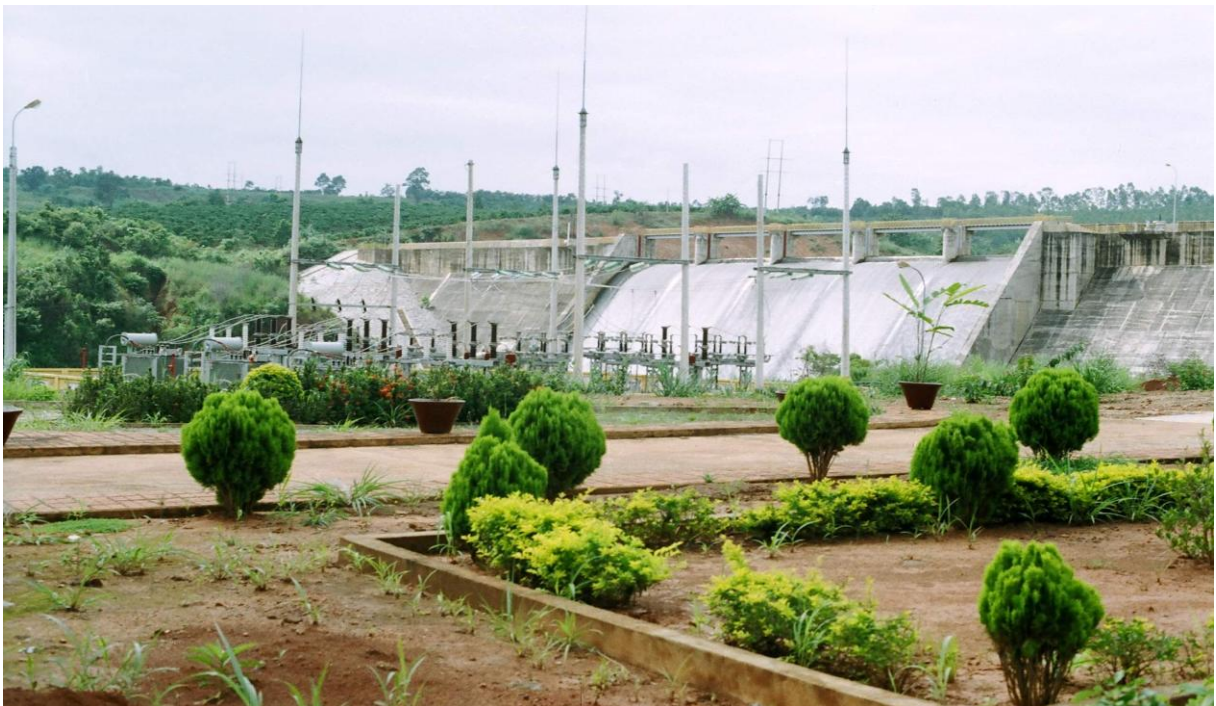
Hình ảnh Nhà máy Thủy điện Ry Ninh II
